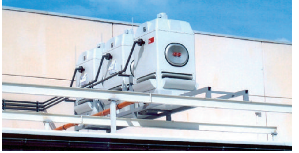
3 adet KT 100 soğutma kulesinden oluşan soğutma kulesi sistemi, en fazla 27 adet Z 2005 W tip modülü su soğutmalı besler.
